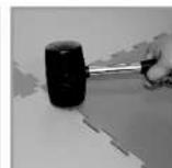
**10.** Покрытие рекомендуется приклеивать **«точечно»** к основанию там, где будет производиться движение легкой техники (весом до 200кг), при значительных пешеходных нагрузках. Клей наносится на основание пола вдоль линии стыковки модулей (не затрагивая зону соединения замковых элементов) и под центром плитки. **Время полного затвердевания: 24 часа.**
