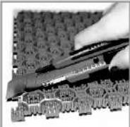
**8.** При монтаже необходимо обращать внимание на то, как ориентированы модули Optima: **углы с фиксатором должны быть направлены в одну сторону.**
